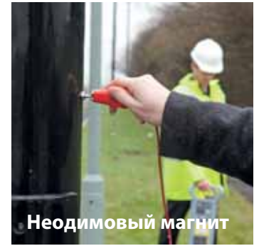
Способ трассировки кабелей малого диаметра
