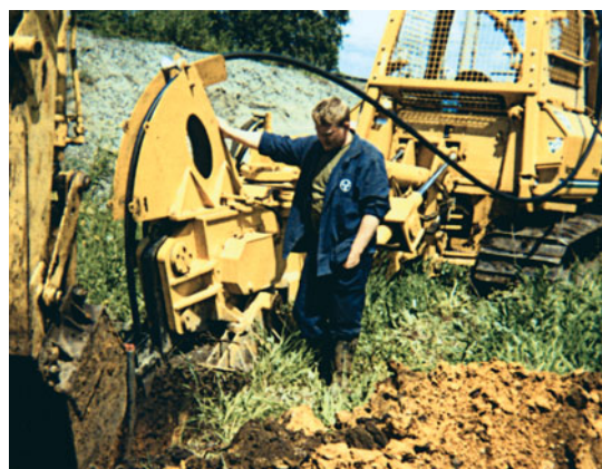
Для повышения надежности сетей необходимо жесткое выполнение технологии строительства ВОЛС
