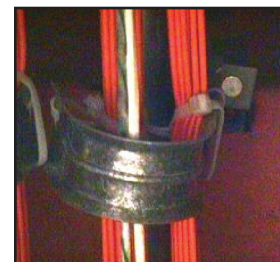
Рисунок 16: Микроизгиб в кабеле приводит к потере мощности, как показано на рефлектограмме (обведено).
